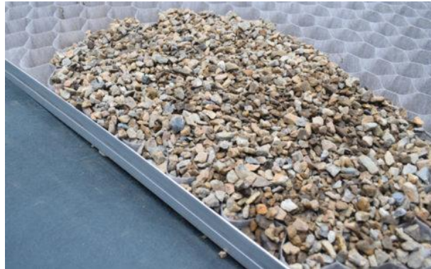
アルミエッジを使用したグランドグリッド™施工
