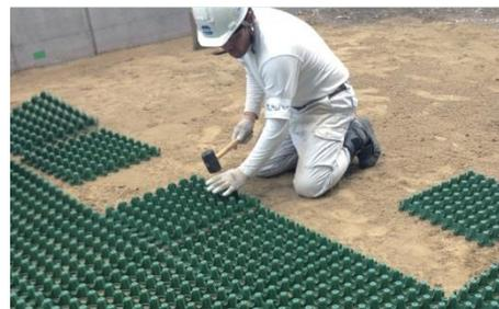
**ローンベース設置** ・ローンベースのタテ、ヨコの1コーナーを決めます。・接合部分は凸部の上に凹部を重ねて上から押し込むようにして組立てます。・一列ごとに前後左右を確認して、ゆがみの無いように調整して下さい。・曲面、角部分は剪定ばさみ等で、本体がはみだした部分をカットします。・車止ローンストッパーを設置する場合は、客土を投入する前のこのタイミングで行います。
