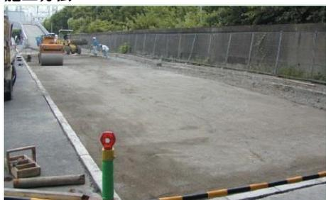
**路盤整地** 200～300mm 下掘りします。・整地後クラッシャーラン(砕石材)0～40を投入します。・十分に転圧(2～4t)整地します
