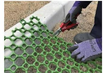
剪定鋏などで、本体がはみだした部分をカットします。その場合も浮き上がる箇所はフット B で押えておきます。
