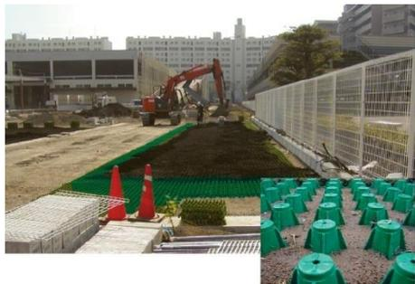
**客土投入** ・敷設後黒土を投入し敷きならします。・竹ぼうきで少し強めにすきとり芝生の厚みを考慮して、ローンベースの先端部が20mm程度露出するようにします。
