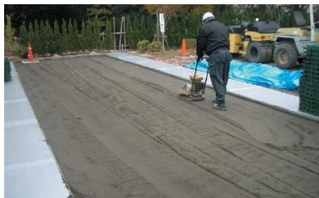
**レベル調整(転圧)** ・レベル調整材(山砂、真砂土、スクリーニングス)を投入敷きならします。・プレートで転圧します。・厚み 5～10mm に仕上げます。・ローンベースの高さGLに合わせます。
