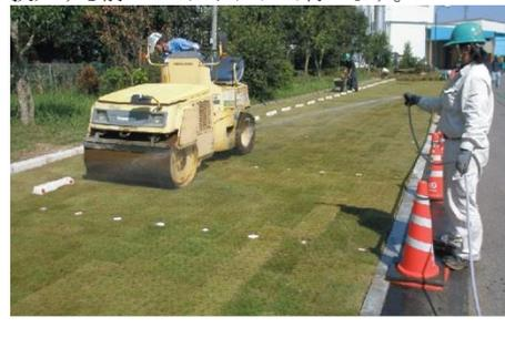
**散水・転圧・目砂** 散水しながら2～4tのローラー転圧をかけます。・化学肥料を散布します。・芝の目砂をし、芝生が根付くまで養生をしてください。
