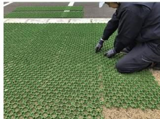
1列ずつジョイントさせたものを施工場所で順次継ぎ合せていきます。
