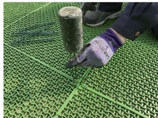
良質土を厚さ200mm以上になるように敷き詰めます。その上に芝生を張ります。芝生の上にローンガードナーLG-07Fを数枚ずつ敷きます。隣接する二枚のローンガードナーを専用金具でとめていきます。
